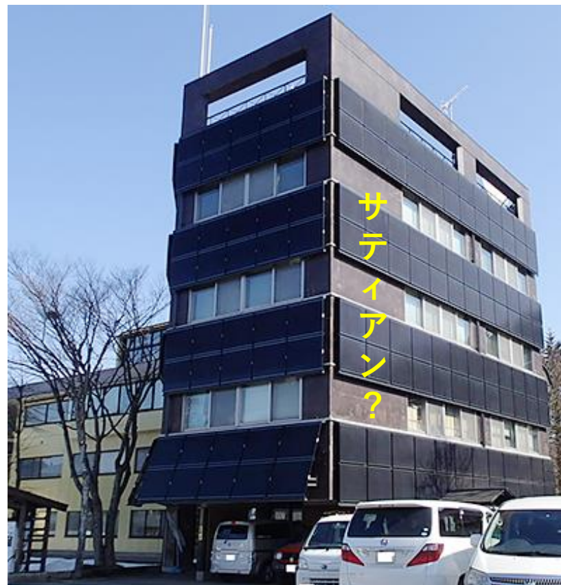
役場の太陽光パネル
